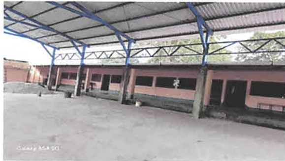
Sustitucion de piso torta lisa por piso ceramico
