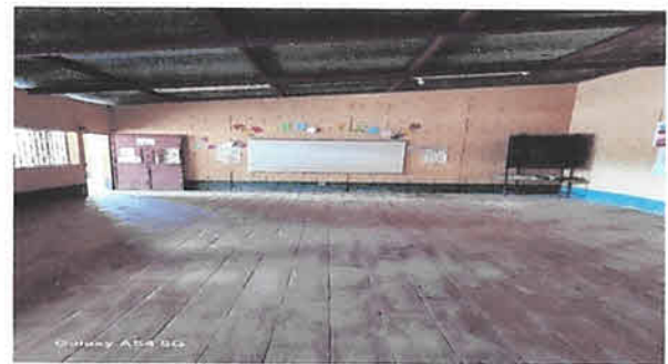
Sustitucion de piso torta lisa por piso ceramico en aulas
